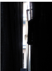
建物間の隙間
